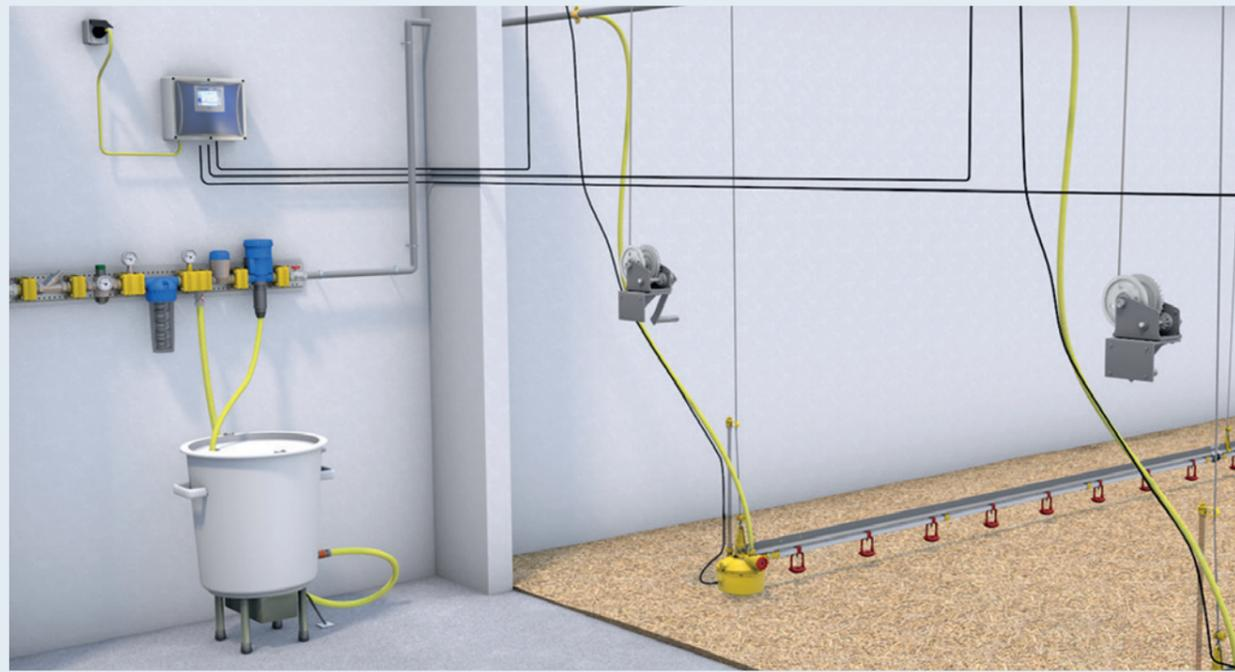
Der Druckminderer Optima E-Control kann neben der Druckregelung mit seinen Aktuatoren auch die Tränkelinien automatisch spülen. Die LUBING Steuerung „Touch Control“ schaltet nacheinander die Aktuatoren, die das integrierte Spülventil der Druckminderer öffnen. Die dafür benötigte Spannung wird von der LCO-Steuerung einheitlich in 24 V DC bereitgestellt.
